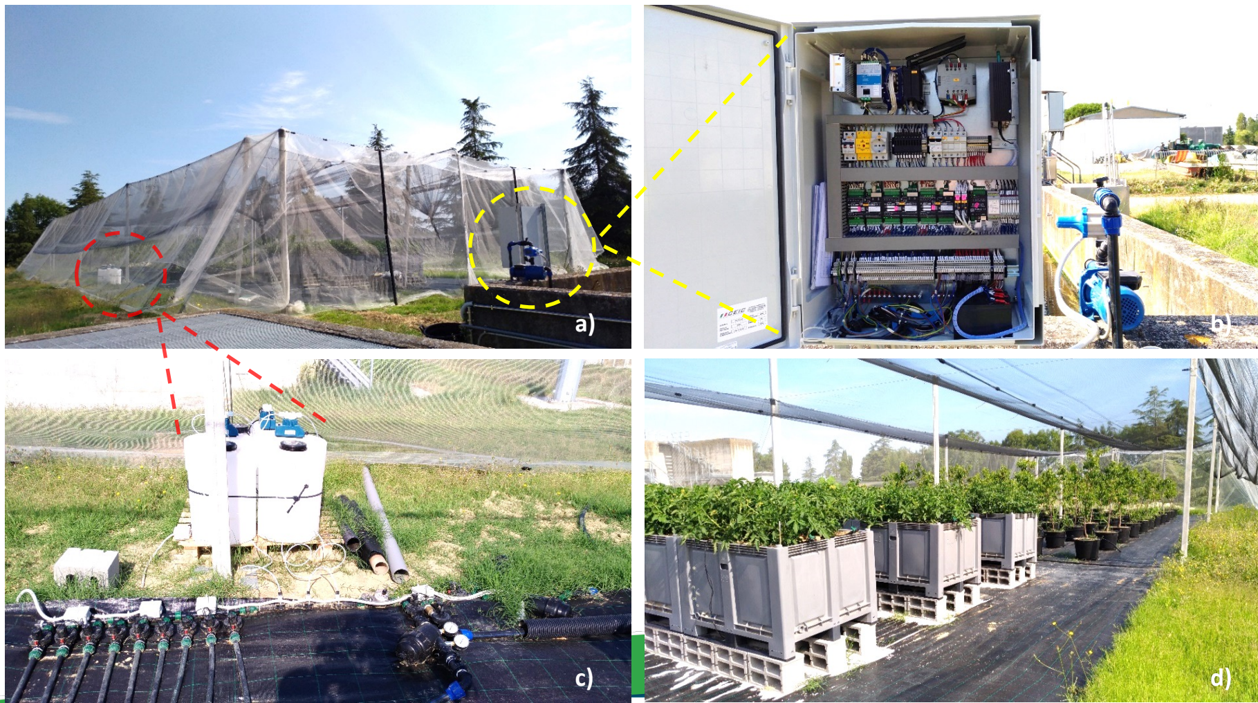
a) area sperimentale sotto rete antigrandine, b) centralina di monitoraggio della qualità delle acque trattate, automazione e controllo della fertirrigazione, c) sistema fertirriguo e d) disposizione delle colture (pomodoro e pesco)
